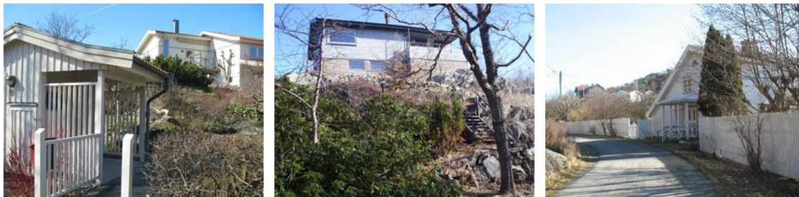
Befintlig bebyggelse på a) Brännö 5:47 b) Brännö 4:172 och c) Brännö 1:44 (Langegården).
